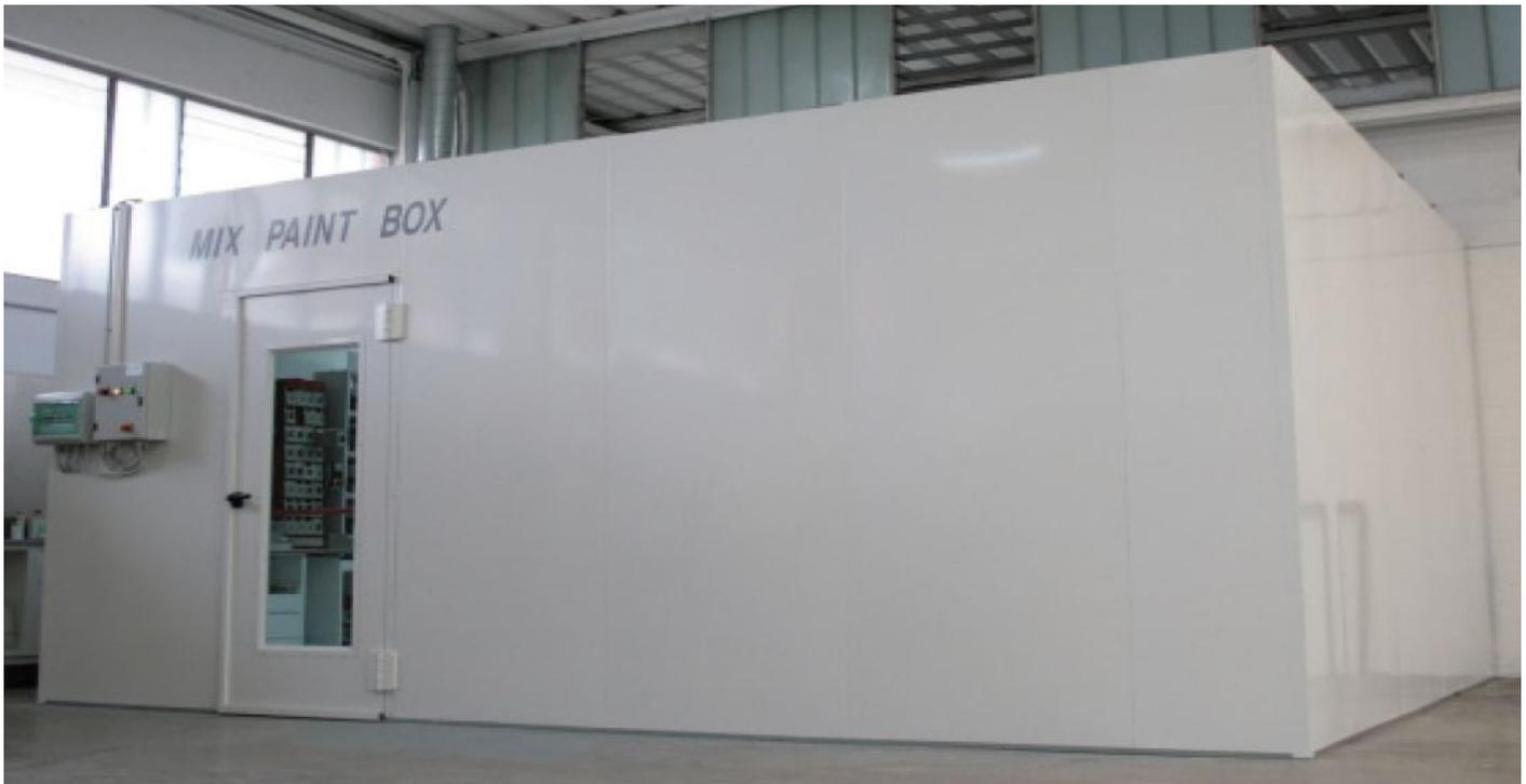
Tous nos laboratoires de stockage peinture sont réalisés avec des panneaux isolés de 52mm d'épaisseur en tôle zinguée prépeinte en blanc. Équipés de plafonnier encastré étanche (le nombre varie selon la dimensions). Asservissement de l'éclairage au renouvellement d'air. Ventilateur d'extraction ATEX, armoire de commandes avec protections et porte de service avec hublot en verre trempé munie d'une barre anti panique. Alimentation 400V triphasé.
