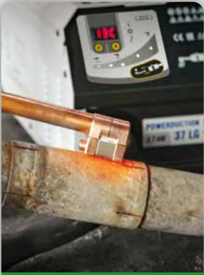
DE-SEALING AN EXHAUST LINE ASSEMBLY - DÉGRIPPAGE LIGNE D'ÉCHAPPEMENT Small S90 Powerduction 37LG
