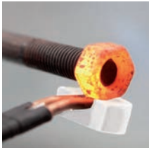
Dégrippage de boulons
